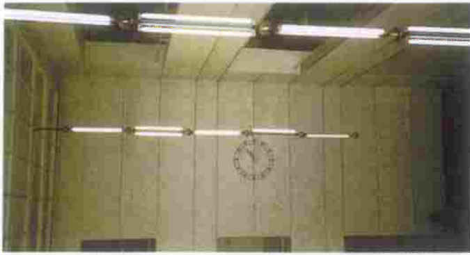
Der Lichthof nach der Renaturierung 1983.
